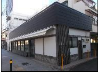
F様店舗外観修景工事 ・赤く明るい屋根を重圧感のある低彩度に変更し縦格子や犬矢来、植栽を設置
